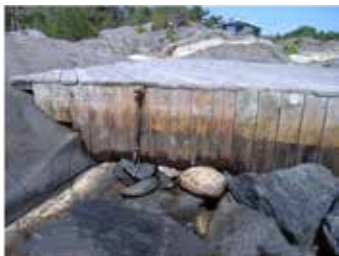
Etter behandling (fortsatt noe fuktig overflate)
